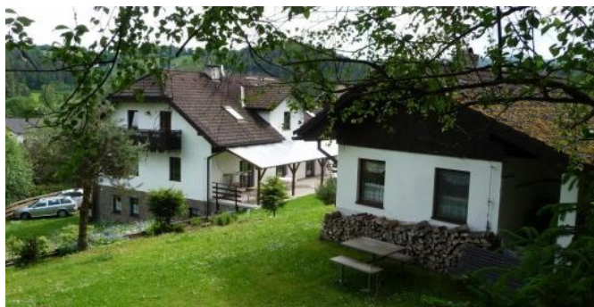
Obr. 19: Penzion Pod Lesem Annín - hlavní budova i chata
