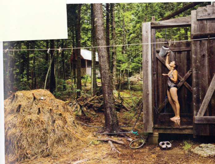
Aerobní bakterie rozkládají kompost, který následně generuje teplo, jím ohřívá vodovodní potrubí. Teplota vody dosahuje v závislosti na ročním období až 65 °C.
