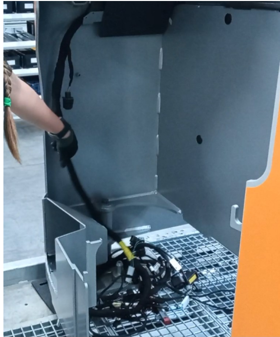
Obrázek 6-35 Kabeláž v kabině
