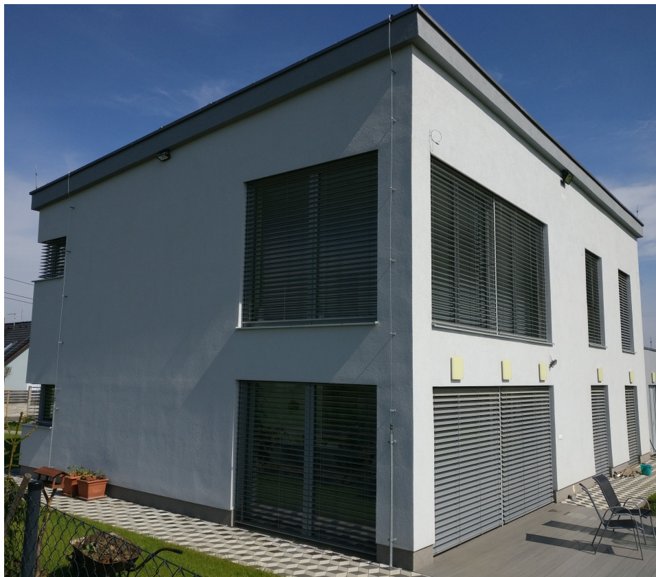
OBRÁZEK 1.4: Příklad venkovních žaluzií instalovaných na domě
