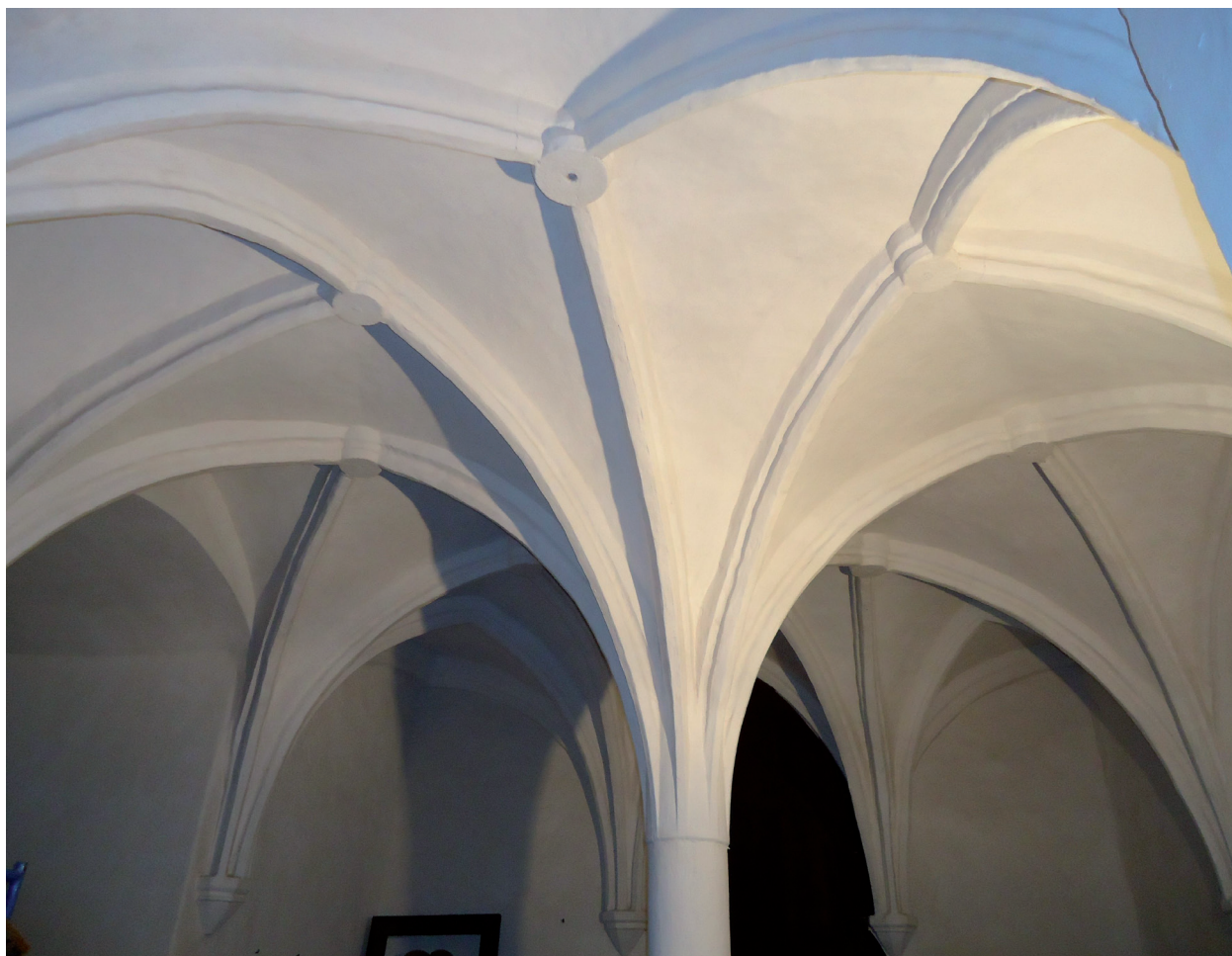
Obr. 8. Detail klenby Románské komory, zaklenuto před rokem 1418. Foto Z. Gersdorfová. – Abb. 8. Detail des Gewölbes der Romanischen Kammer, erbaut vor dem Jahr 1418. Foto Z. Gersdorfová.
