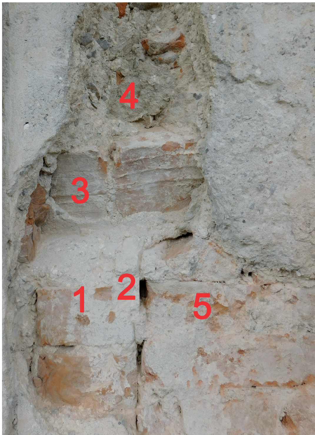
Obr. 21. Holešov zámek. Detail paty klenby pozdně gotického arkýře. 1 – zdivo z vysokých, v líci zčásti osekáných pozdně gotických cihel, 2 – špaleta boční zdi někdejšího arkýře s hlazenou a líčenou omítkou, 3 – pata odstraněné klenby interiéru arkýře, 4 – jizva po cihlách někdejší paty, 5 – cihlové zdivo z doby krátce po polovině 17. století. Foto Jan Štětina 2016. – Abb. 21. Holešov (Bezirk Kroměříž), Schloss. Detail des Gewölbefußes eines spätgotischen Erkers. 1 – Mauerwerk aus hohen, an der Sichtseite teils behauenen spätgotischen Ziegeln, 2 – Laibung der Seitenwand des einstigen Erkers mit geglättetem, dünnem Putz, 3 – Fuß des abgerissenen Gewölbes des Erkerinnenraums, 4 – von den Ziegeln des einstigen Fußes zurückgebliebene Narbe, 5 – Ziegelmauerwerk aus der Zeit kurz nach der Mitte des 17. Jahrhunderts. Foto Jan Štětina 2016.
