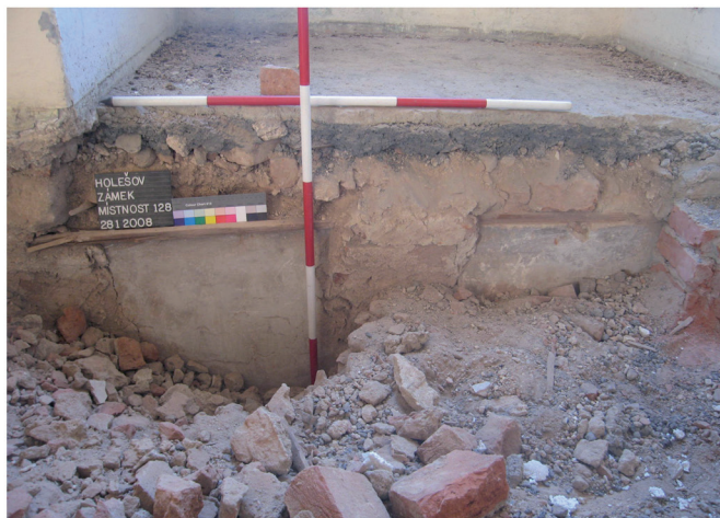
Obr. 28. Holešov zámek. Vpravo nález omítek a zazděného otvoru po uložení trámu renesančního stropu nad klenbou severozápadní místnosti přízemí; vlevo lokalizace nálezu na půdorysu 1. patra. Foto Jiří Janál 2008, kresba Jan Štětina 2015. – Abb. 28. Holešov (Bezirk Kroměříž), Schloss. Rechts gefundener Putz und zugemauertes Balkenloch für die Renaissancedecke über dem Gewölbe des nordwestlichen Raums im Erdgeschoss; links Verortung des Funds im Grundriss des 1. Stockwerks. Foto Jiří Janál 2008, Zeichnung Jan Štětina 2015.
