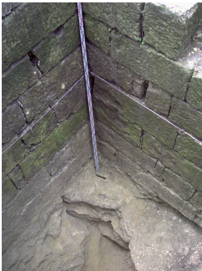
Fig. 6. Pińczów, SE walls inside tower. A. Andrzejewski.
