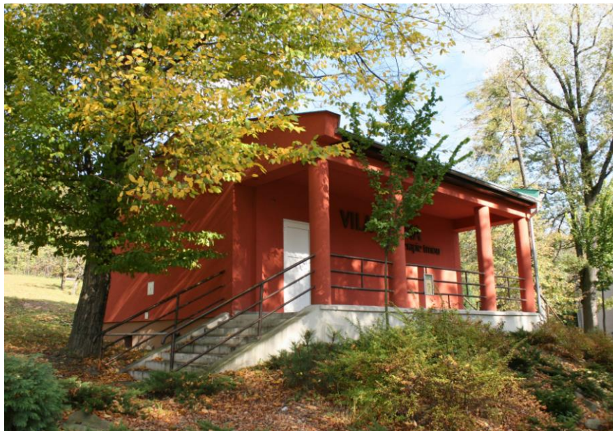
Obr. 1: Objekt v Beskydském rehabilitačním centru Čeladná.
