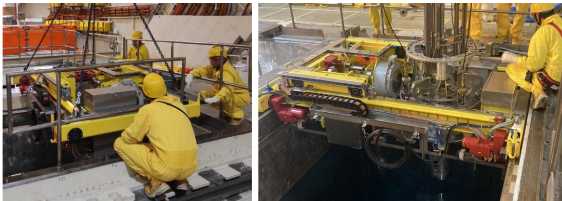
Obr. 3: Vlevo montáž mostu na koleje, vpravo montáž sloupu do mostu SI-PS
