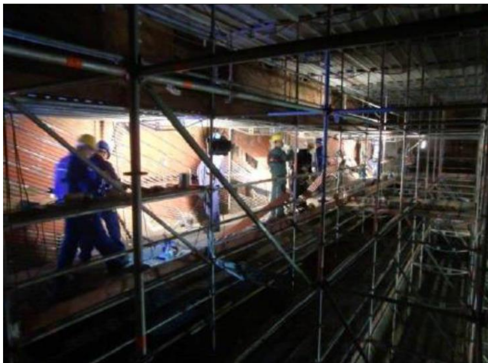
Obr. 17: Kotel elektrárny Schwarze Pumpe – životnost nástříku < 5 let
