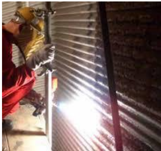
Obr. 3: Žárový nástřik plamenem – v 90. letech používaná technologie – povlaky na bázi NiCr; z ekonomických důvodů nahrazena technologií žárového nástřiku elektrickým obloukem
