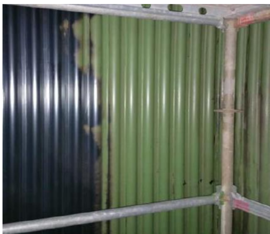
Obr. 10: Keramika po roce provozu, fluidní kotel
