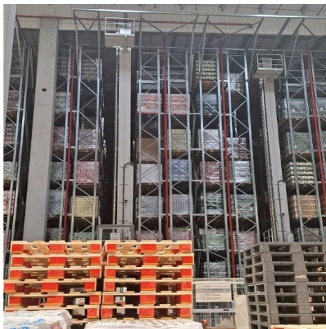
Obr. 14: Automatizované paletové regály s pohledem na uličky se zakladačem
