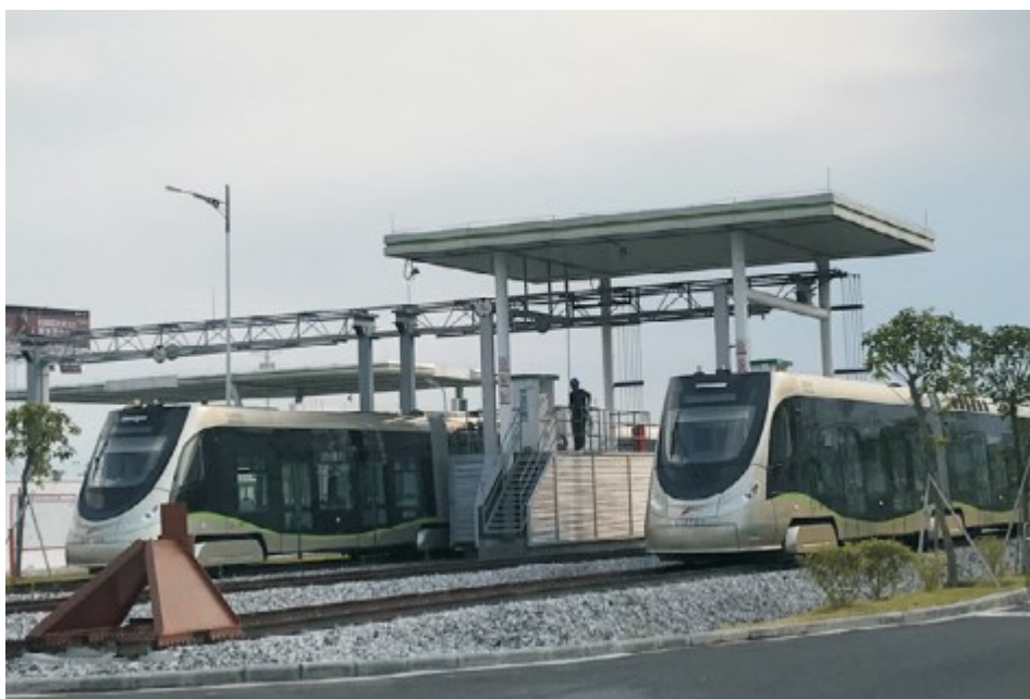
Obrázek 21 - Plnicí stanice pro tramvaje
