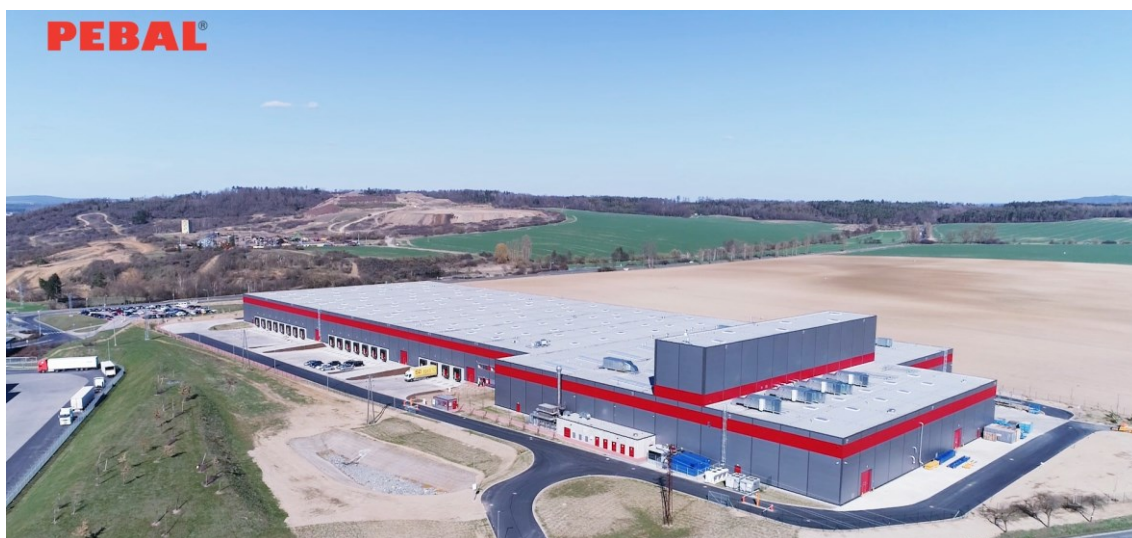
Obr. 10: Výrobní hala v Dobřanech
