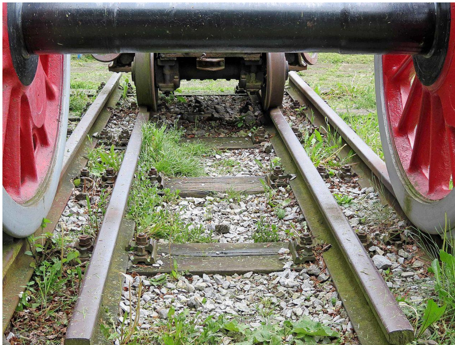
Obrázek 16 - Rozdíl mezi úzkorozchodnou a běžnou železniční tratí [19]
