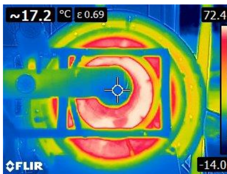
Obrázek 71 Termogram zařízení – termo-kamera FLIR
