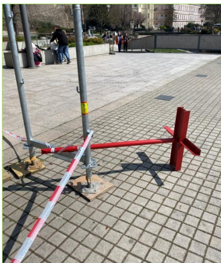
Fotografie 2: Značení staveniště.
