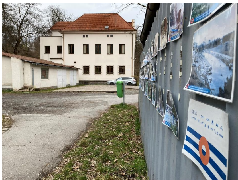
Obr. č. 3 – Stav Plovárny 11. 3. 2023; Zdroj: autor.
