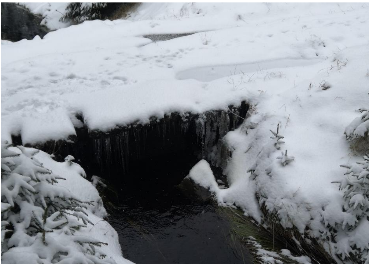
Obrázek 49: O13 – Betonový most (archiv autora).
