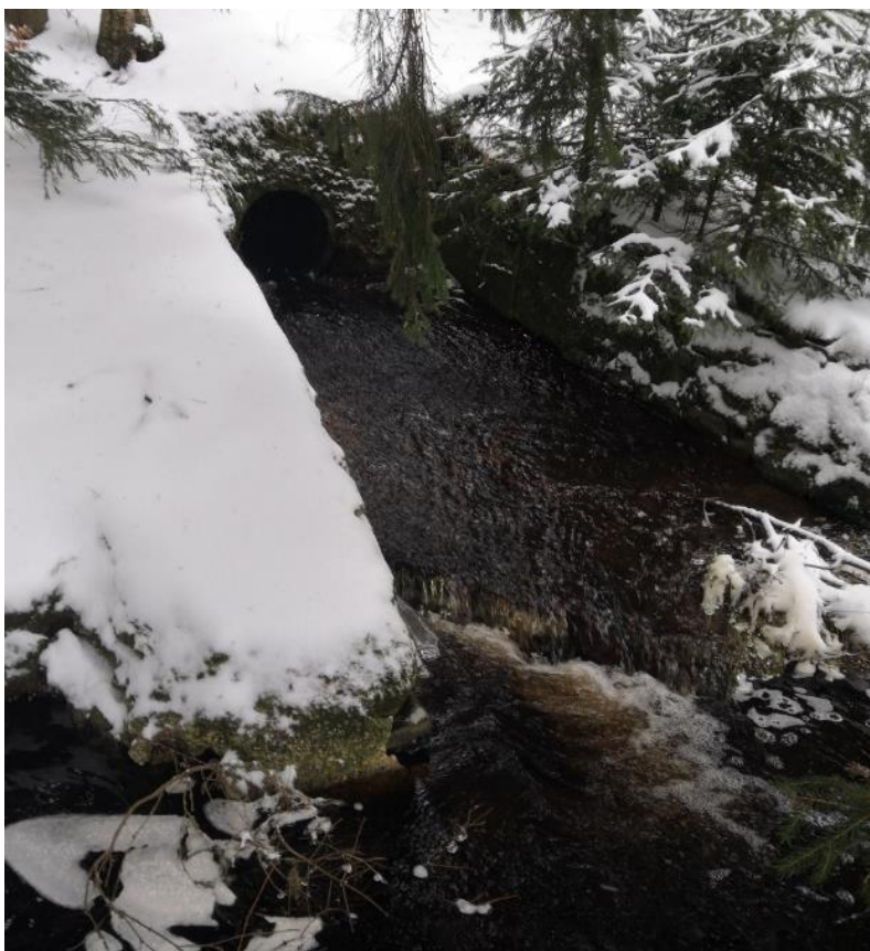
Obrázek 39: O5 – Betonová výpust Kladského rybníka (archiv autora).
