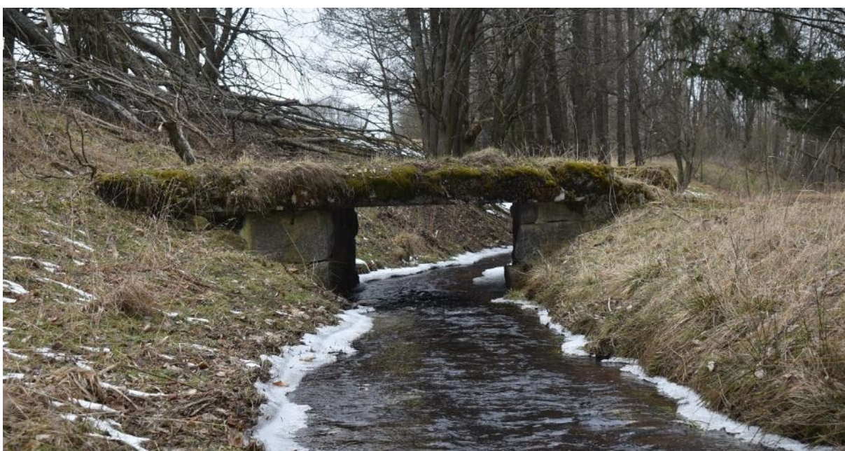
Obrázek 98: O36 – Betonový most (archiv autora).
