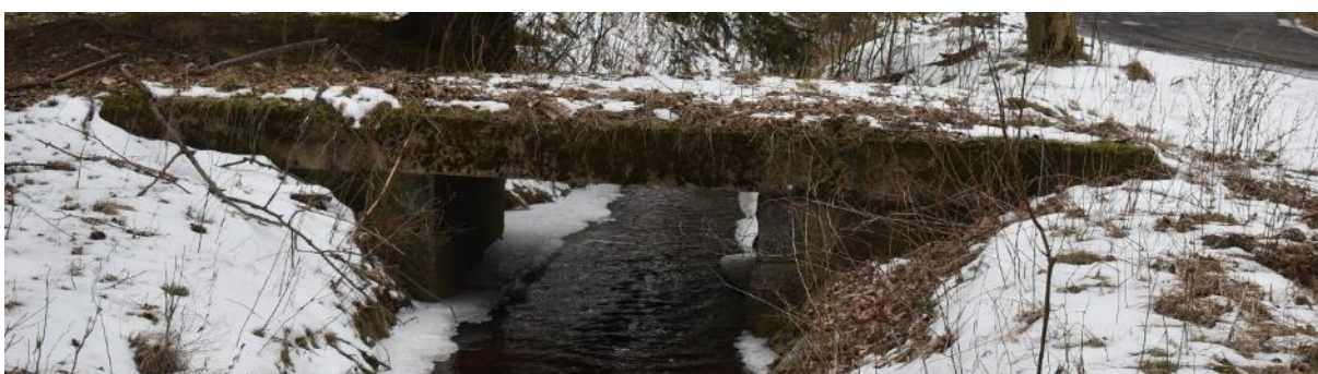
Obrázek 105: O45 – Betonový most (archiv autora).
