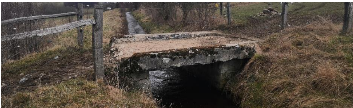
Obrázek 133: O64 – Betonový most (archiv autora).
