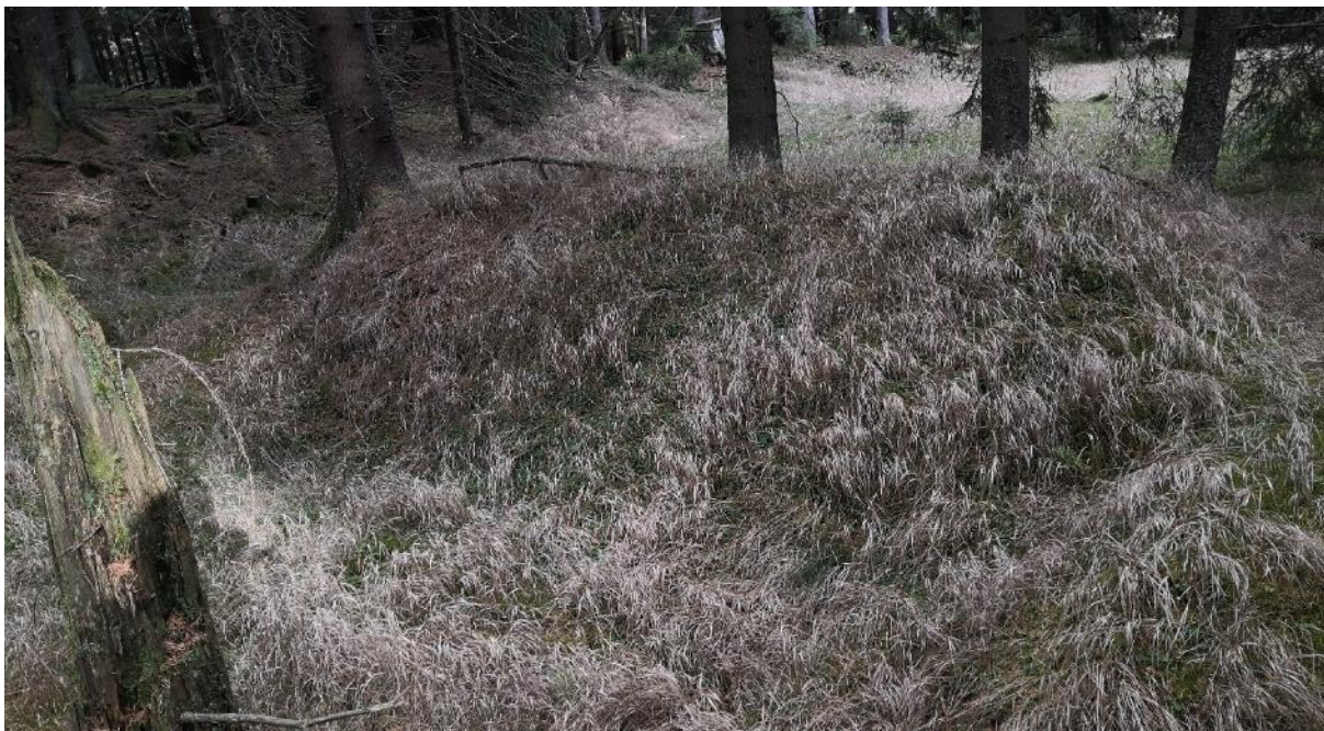
Obrázek 86: Detail pozůstatků hráze třetího rybníka (archiv autora).
