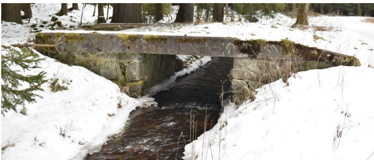
Obrázek 108: O47 – Betonový most (archiv autora).
