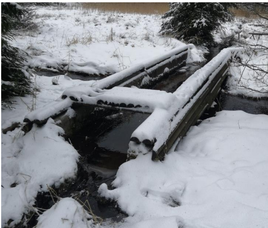
Obrázek 40: O6 – Betonový akvadukt obložený dřevem, kterým Pramenský potok překonává Dlouhou stoku (archiv autora).
