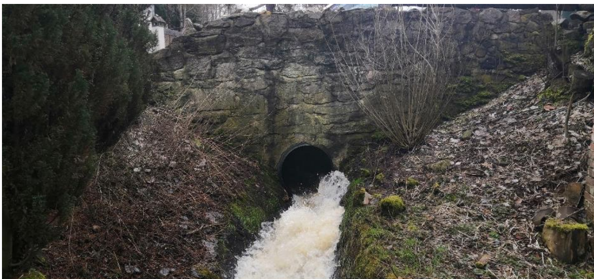
Obrázek 138: O68 – Kamenný most s kovovou trubkou pro kanál (archiv autora).
