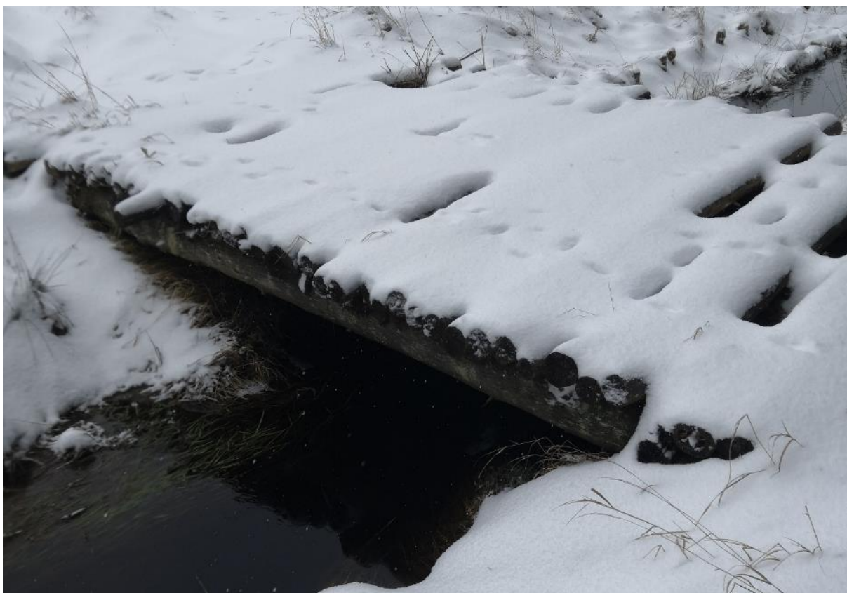
Obrázek 50: O15 – Dřevěný most bez základů (archiv autora).
