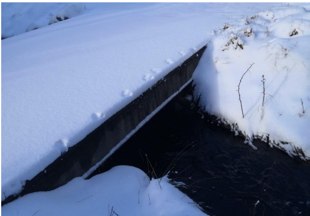
Obrázek 71: O24 – Betonový most tvořený deskou bez základů (archiv autora).
