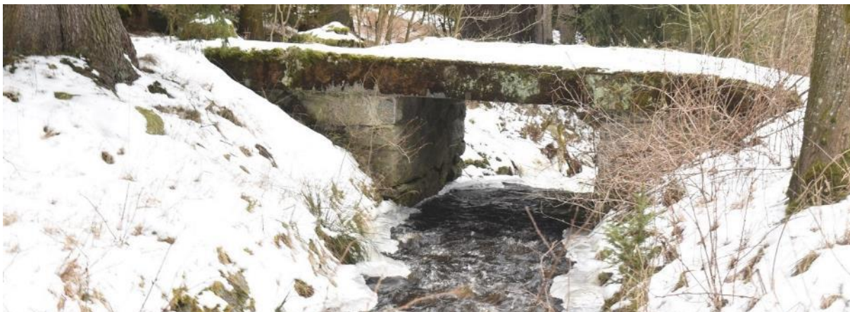
Obrázek 106: O46 – Betonový most (archiv autora).
