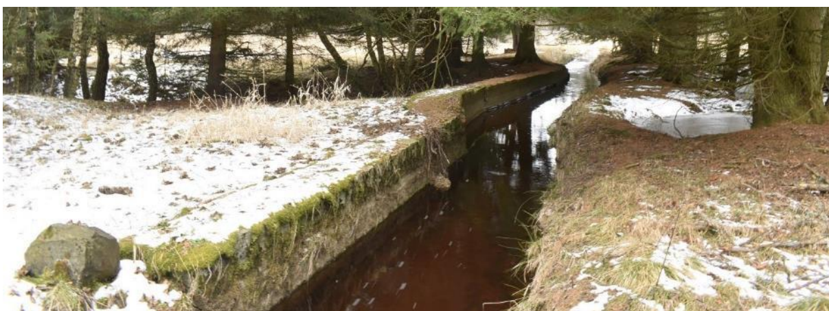
Obrázek 92: O31 – Pravobřežní zeď, kamenná (vpředu) a betonová (vzadu) část (archiv autora).
