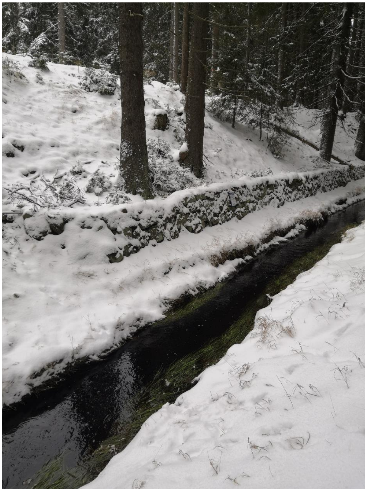
Obrázek 52: O14 – Začátek levobřežní kamenná zdi (archiv autora).
