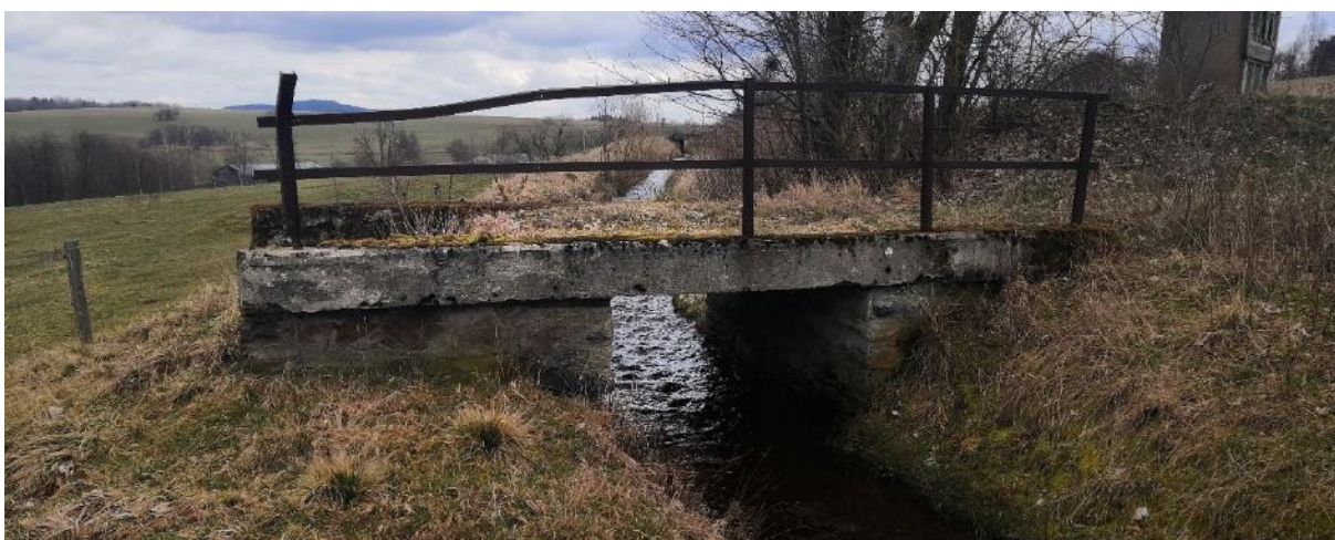
Obrázek 134: O65 – Betonový most (archiv autora).
