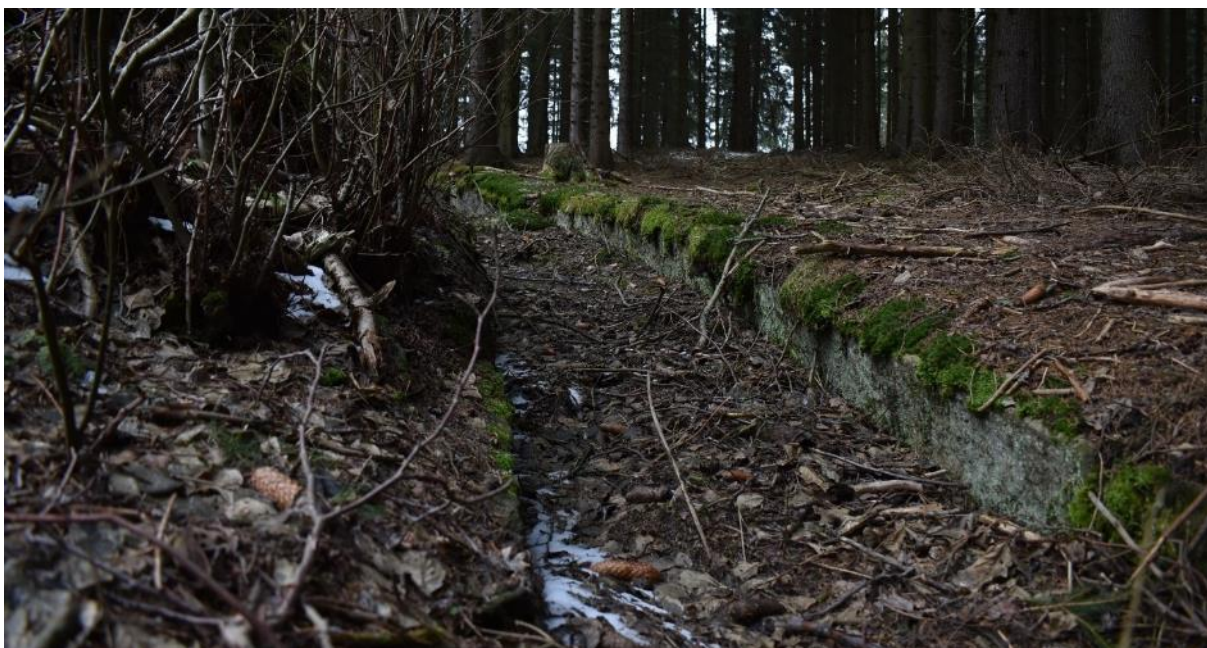
Obrázek 120: O57 – Kanálek z přelivu rybníka Himmelteich (archiv autora).
