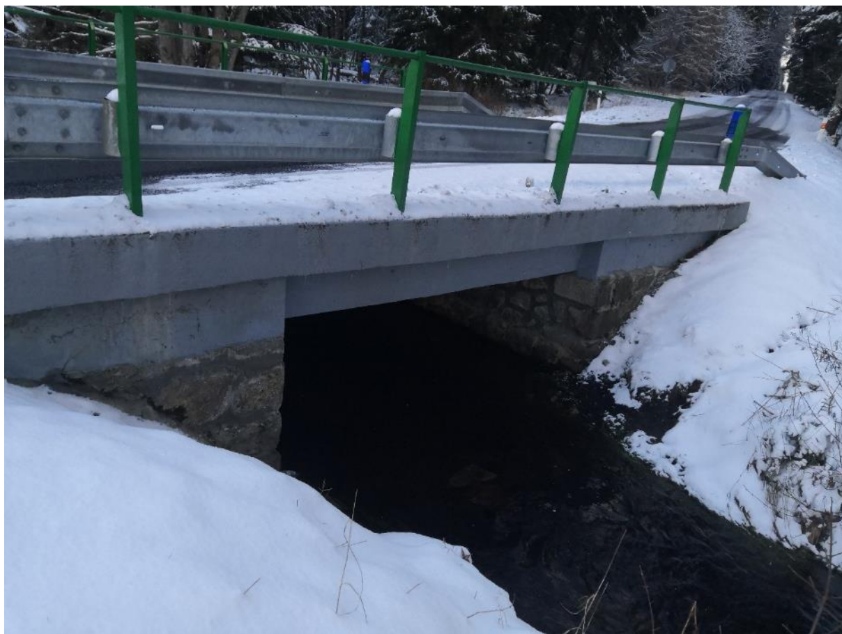
Obrázek 73: O26 – Betonový most pro silnici z Pramenů do Sokolova (archiv autora).
