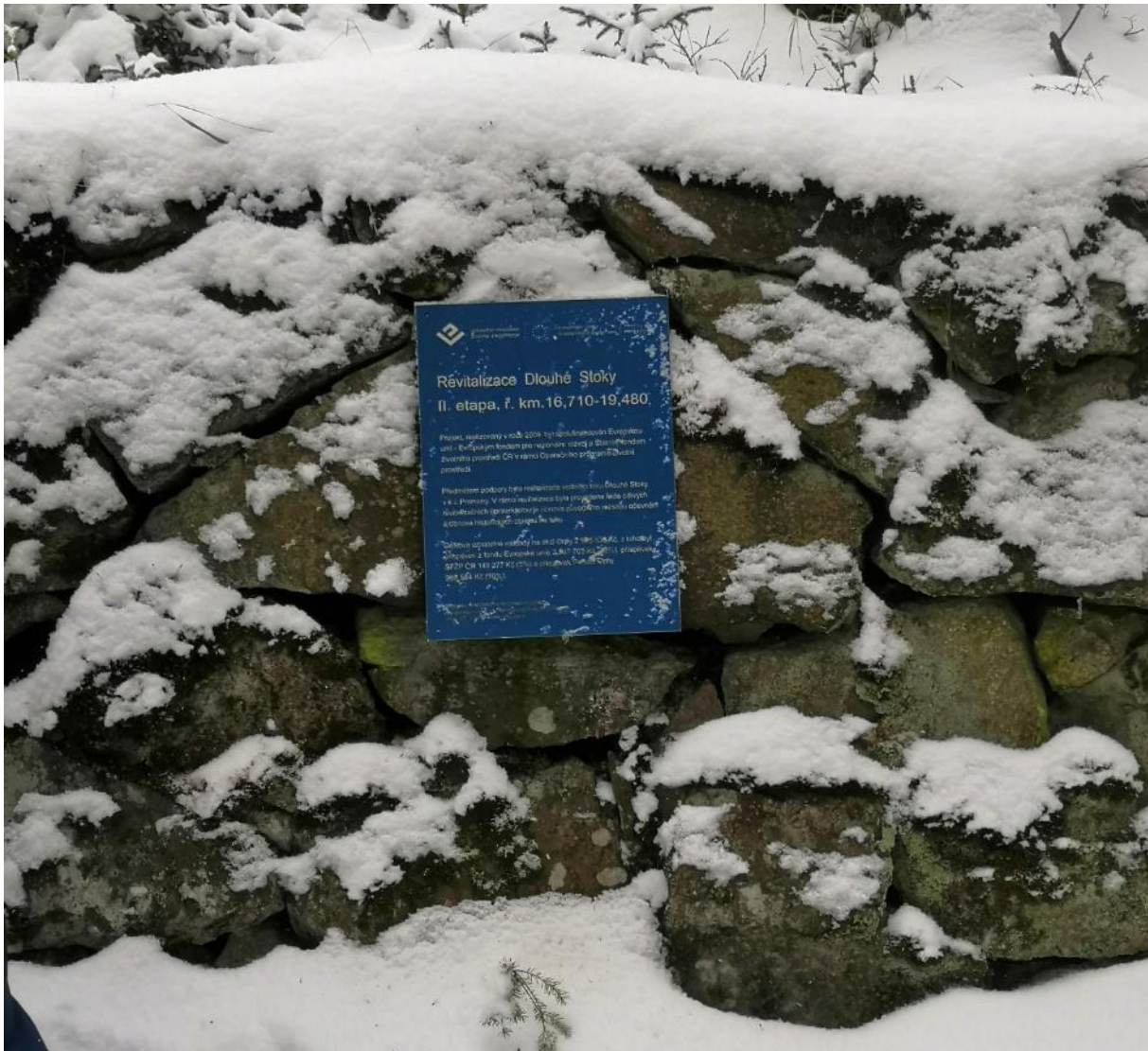
Obrázek 55: O14 – Levobřežní kamenná zed' s cedulkou informující o proběhlé revitalizaci (archiv autora).
