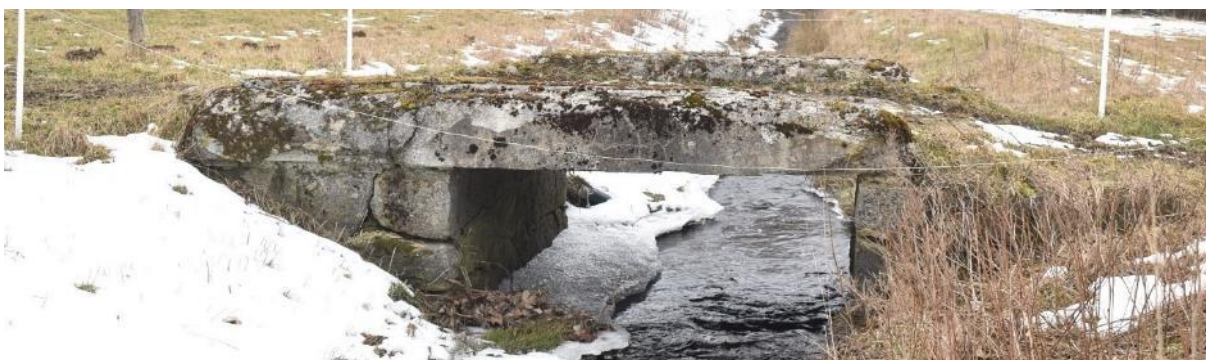
Obrázek 103: O42 – Betonový most (archiv autora).
