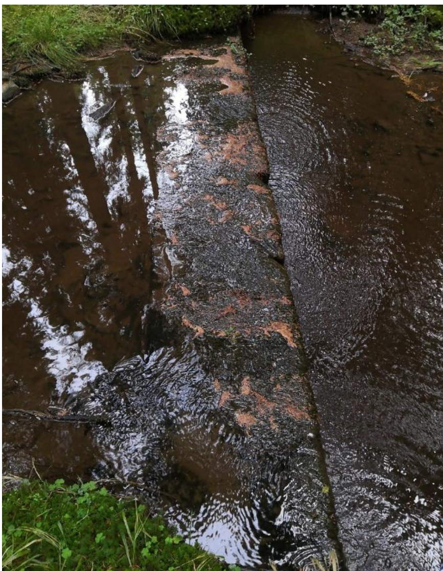
Obrázek 62: Kamenný práh na přítoku z Mýtského rybníka, pohled z boku (archiv autora).
