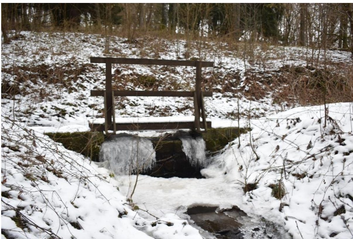
Obrázek 126: O60 – Kamenný rozdělovací objekt (archiv autora).
