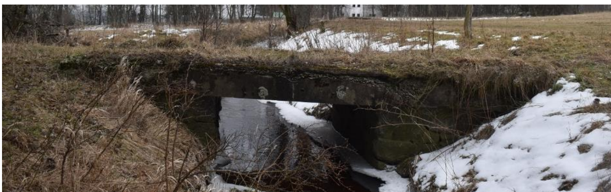
Obrázek 104: O43 – Betonový most (archiv autora).
