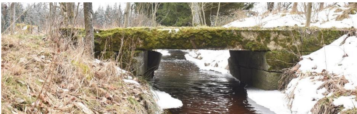
Obrázek 94: O34 – Betonový most (archiv autora).
