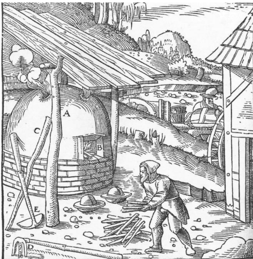
Pec A. Násypný otvor B. Hřeblo C. Hřeblo se dvěma zuby D. Pohrabáč E.
