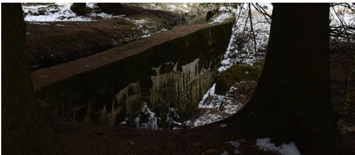
Obrázek 90: O31 – Pravobřežní betonová zeď (archiv autora).
