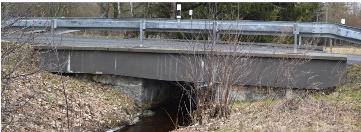
Obrázek 113: O51 – Betonový most pro silnici z Nové Vsi k silnici č. 210 (archiv autora).
