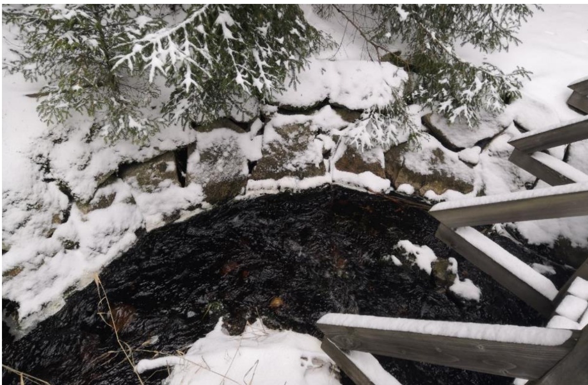
Obrázek 37: O3 – Dřevěná lávka a kamenná zídka (archiv autora).
