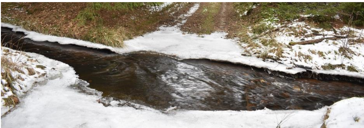
Obrázek 118: O54 – Brod z betonových desek (archiv autora).
