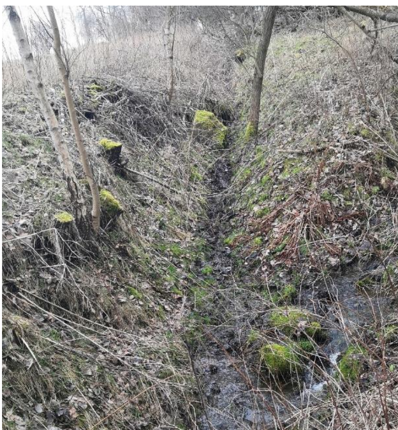
Obrázek 154: Příkop ve tvaru V pod zaniklým Dlouhým rybníkem (archiv autora).
