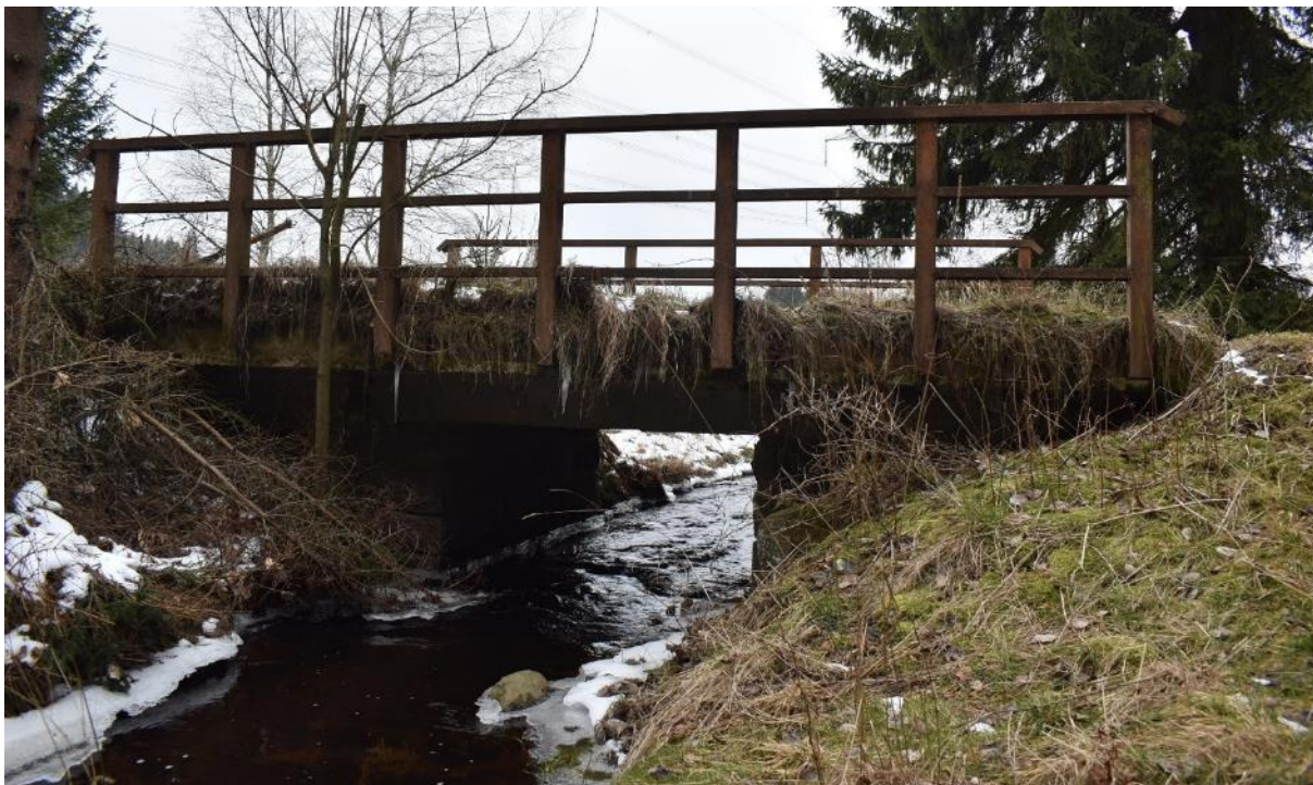
Obrázek 109: O48 – Betonový most (archiv autora).
