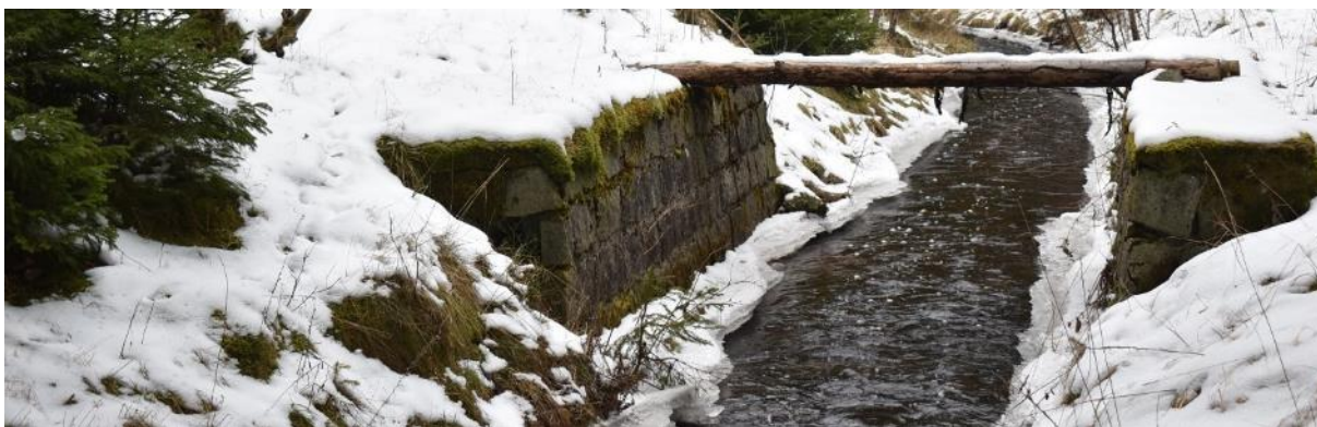
Obrázek 119: O55 – Kamenné základy zaniklého mostu (archiv autora).
