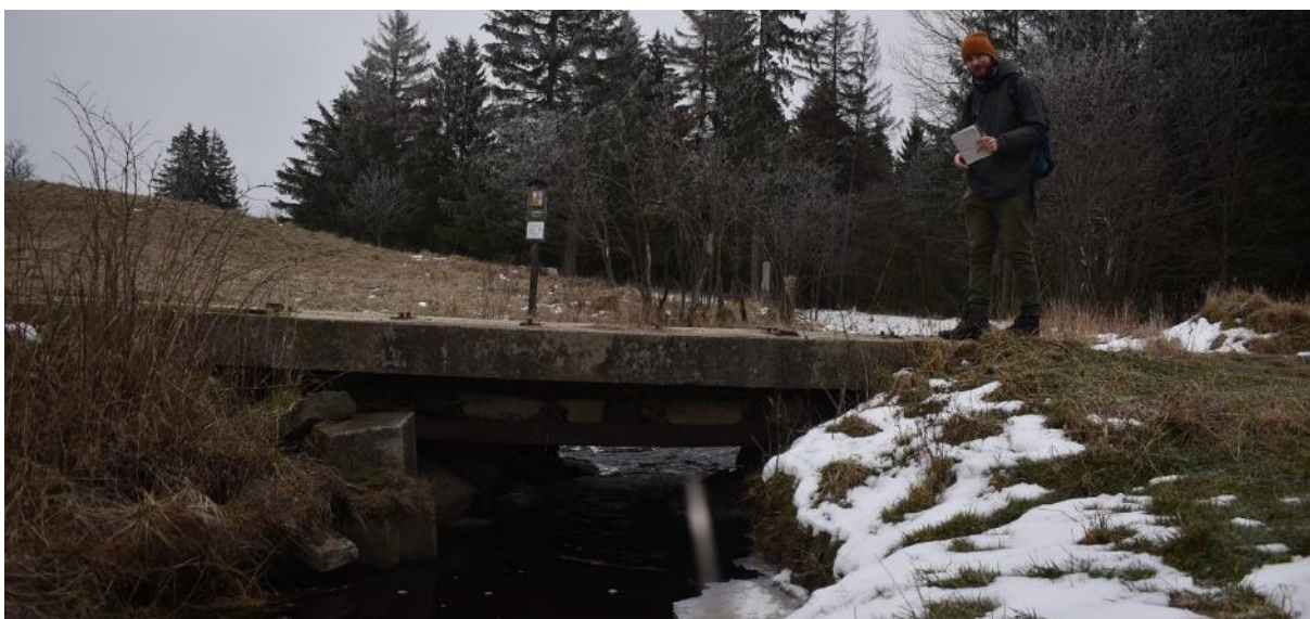
Obrázek 76: O27 – Betonový most (archiv autora).
