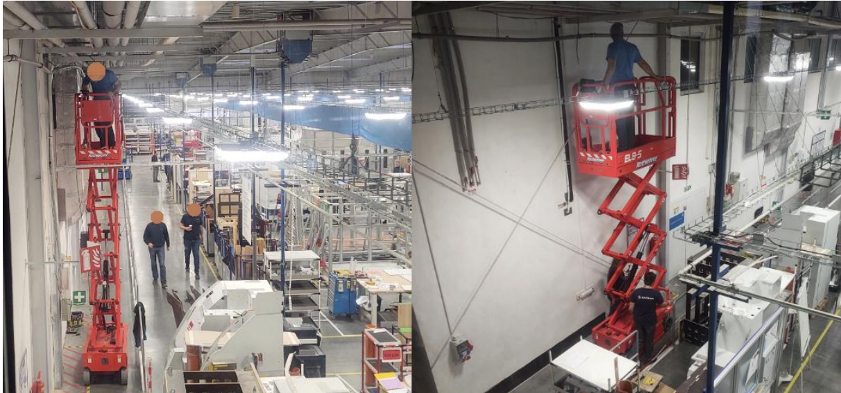
Obr. 4.9-1 práce na vysoko zdvižné plošině
