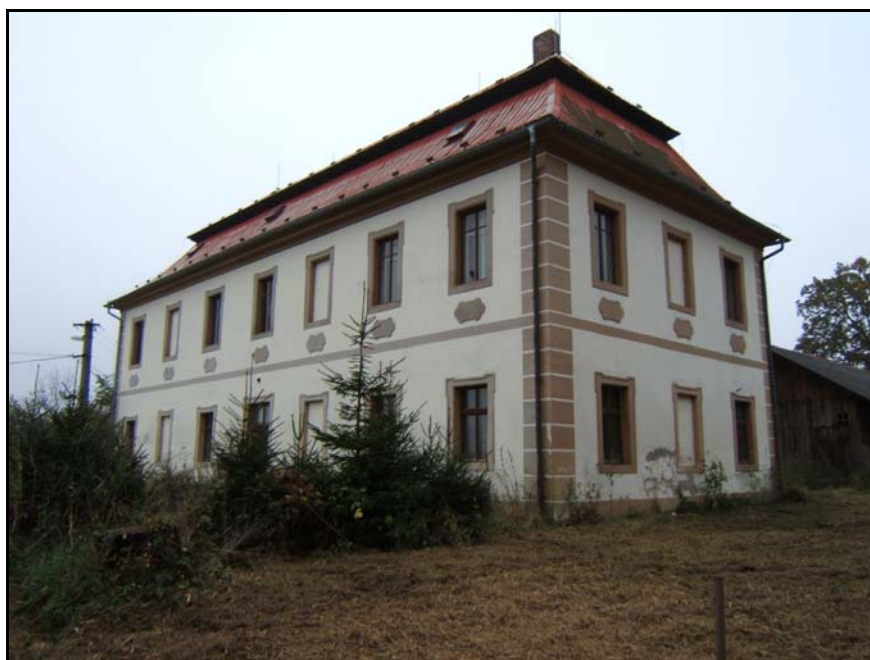
Obr. 10: Maníkovice (okr. Mladá Boleslav) – lovecký zámek na okraji obory Klokočka. Pro tento typ staveb je charakteristická obdélná dispozice a mansardová střecha. Foto: autor, říjen 2008.
