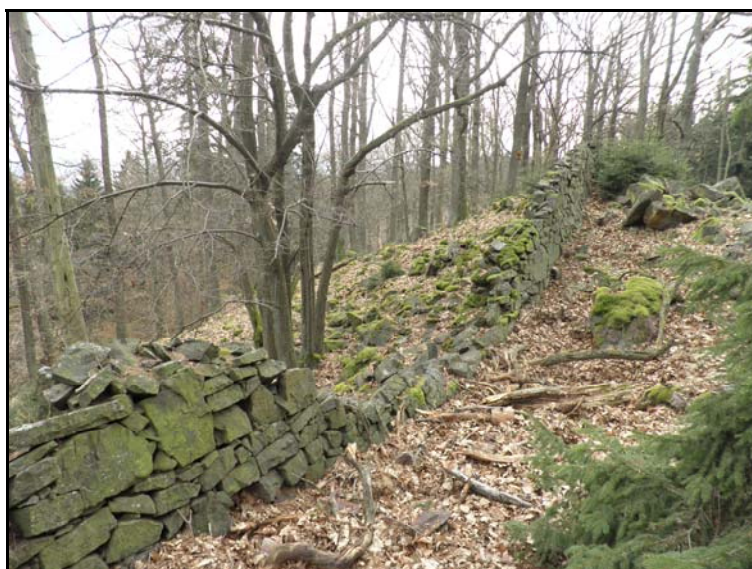
Obr. 34: Zeď oddělující panství Hluboš a Jince (okr. Příbram) – na sucho skládaná zeď z materiálu z místní horninové báze. Foto: autor, duben 2012.
