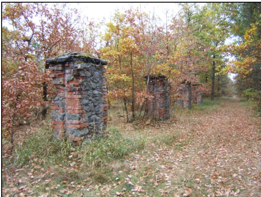
Obr. 15: Obora Králova stolice u Dobříše (okr. Příbram) – oborní sloupky na západní straně obory. Foto: autor, listopad 2006.
