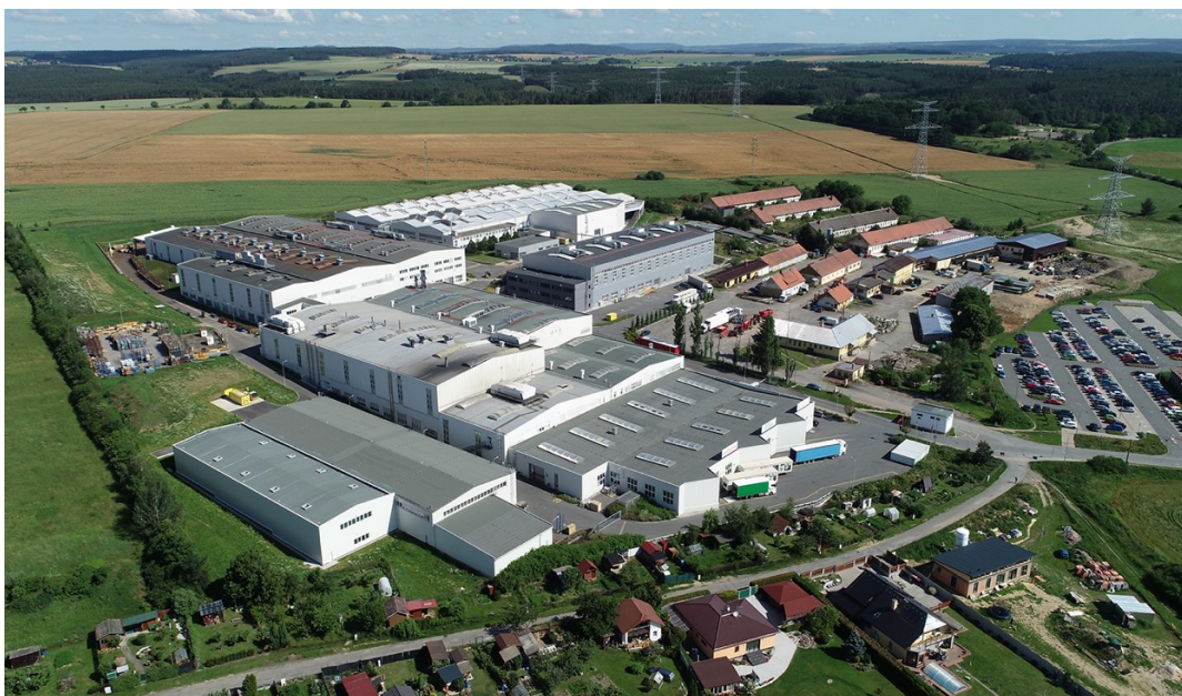
Obr. č. 13: Závod Kermi s.r.o. ve Stříbře
