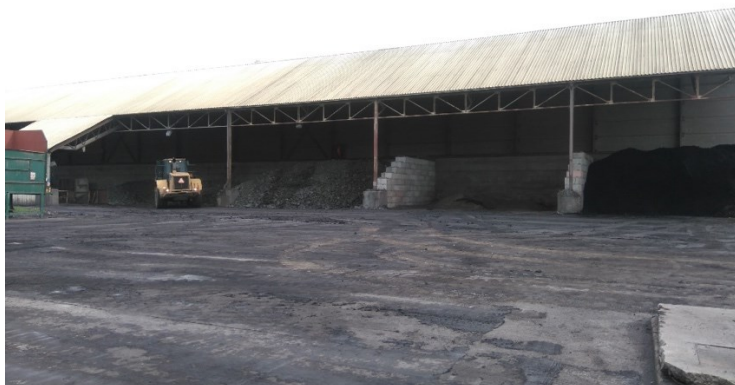
Obr. č. 16: Sklady pro jíl a vápenec
