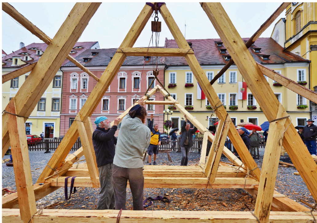
Obrázek 12: Vzyčování repliky nejstaršího krovu (foto archiv TIC Cheb).
