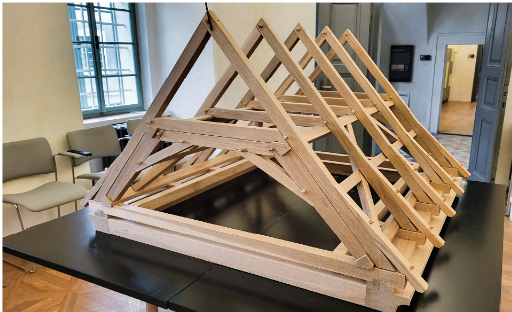
Obrázek 33: Model krovu podélně vázaného ležatou stolicí sestavený na velkém jednácím stole během doprovodného programu konference Dějiny staveb 2023 v Plasích (foto Ľubor Suchý).
