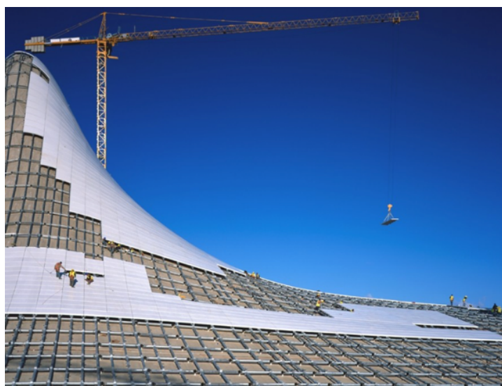
Obrázek 2.44: Pokládka panelů na budovu [64]
