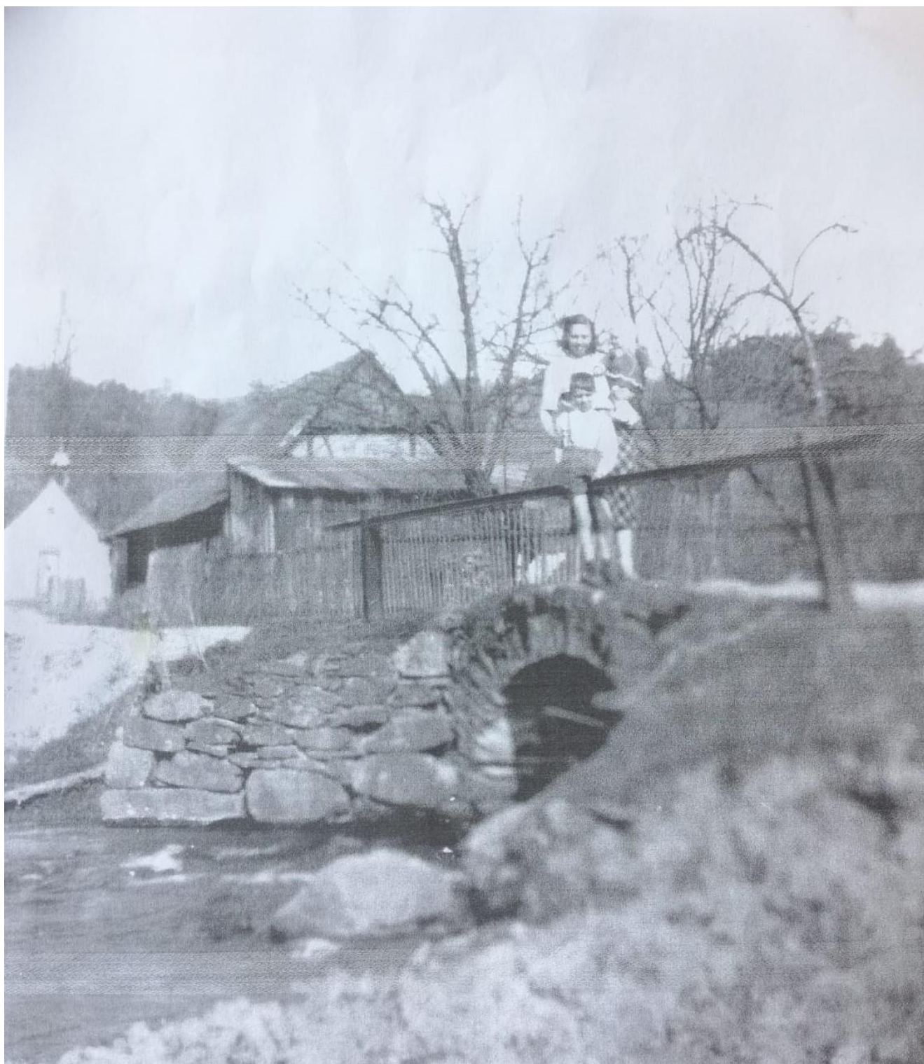
Obrázek 186) Původní mostek v Těšově před obetonováním.
