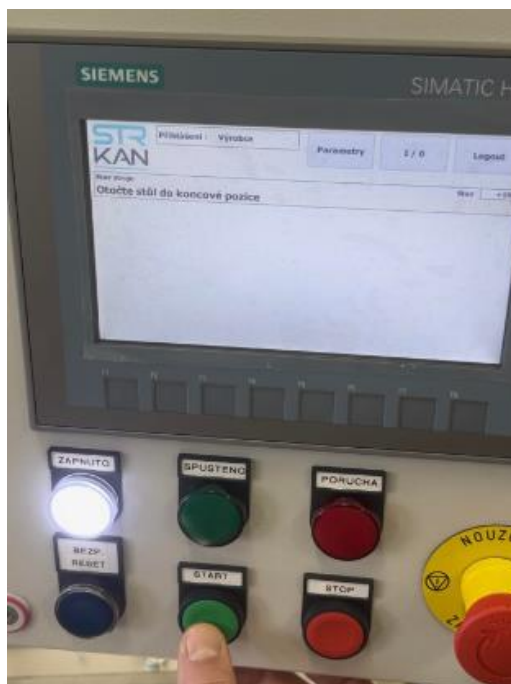
Obrázek 82 - Ovládací panel Siemens KTP700 Basic v rozvaděči
