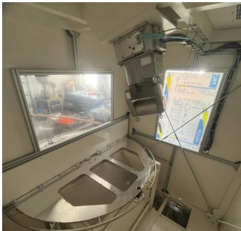
Obrázek 93 - Pohled na vnitřek zařízení před dokončením 1
