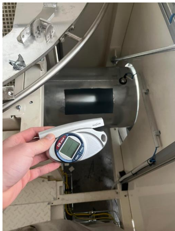
Obrázek 95 - Pohled na vnitřek zařízení před dokončením 3
