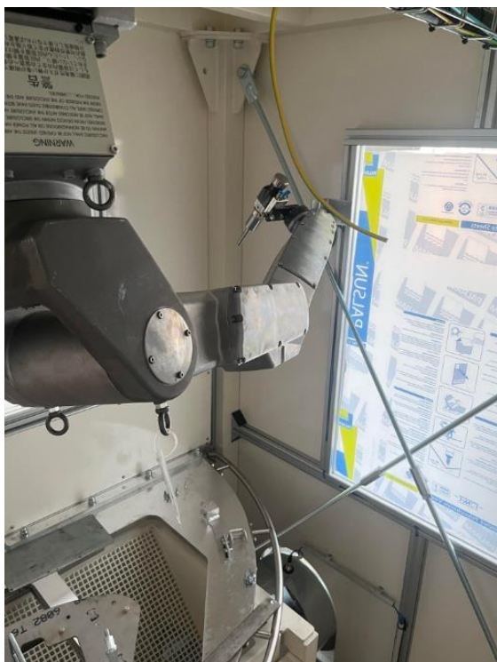
Obrázek 94 - Pohled na vnitřek zařízení před dokončením 2
