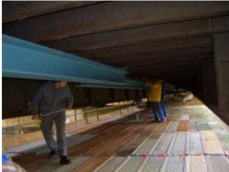
Obrázek 30: Připevnění podélného nosníku [19]
