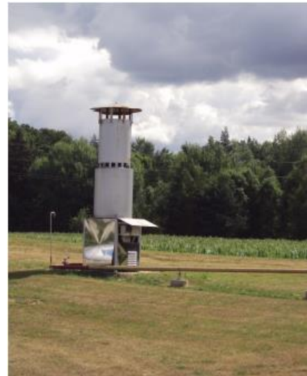
Obrázek 6 – bezpečnostní fléra BPS Vejprnice
