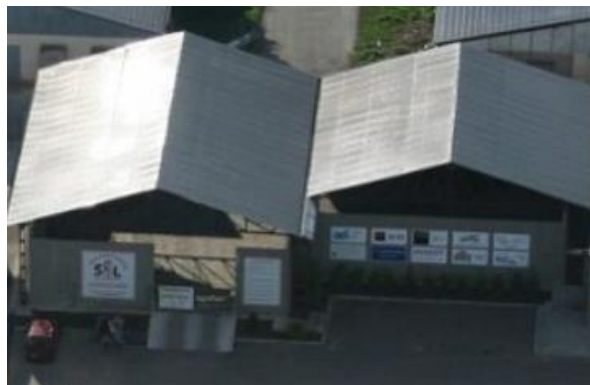
Obrázek 44 - pohled na stávající budovu[13]
