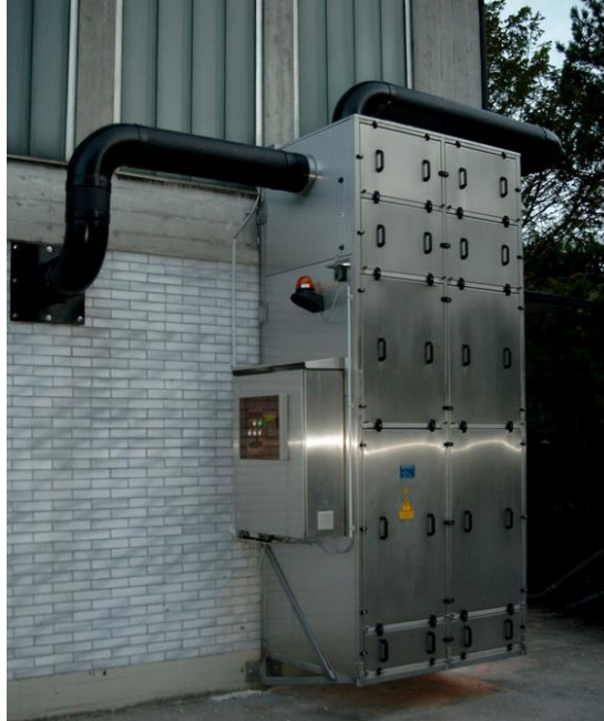
Obrázek 42 – filtrační jednotka AS – PCO[30]
