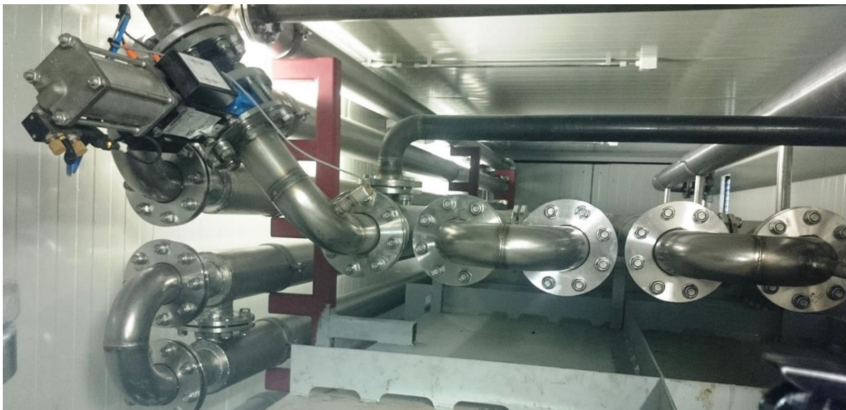
Obrázek 33 – Trubková hygienizace BioG[22]
