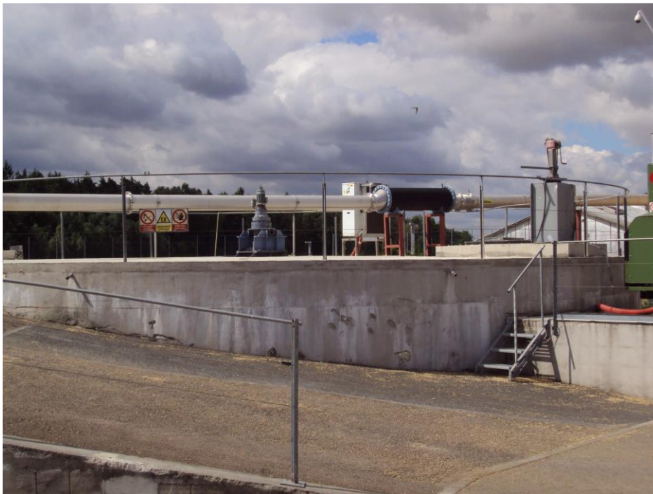
Obrázek 3 – betonový předfermentor BPS Vejprnice
