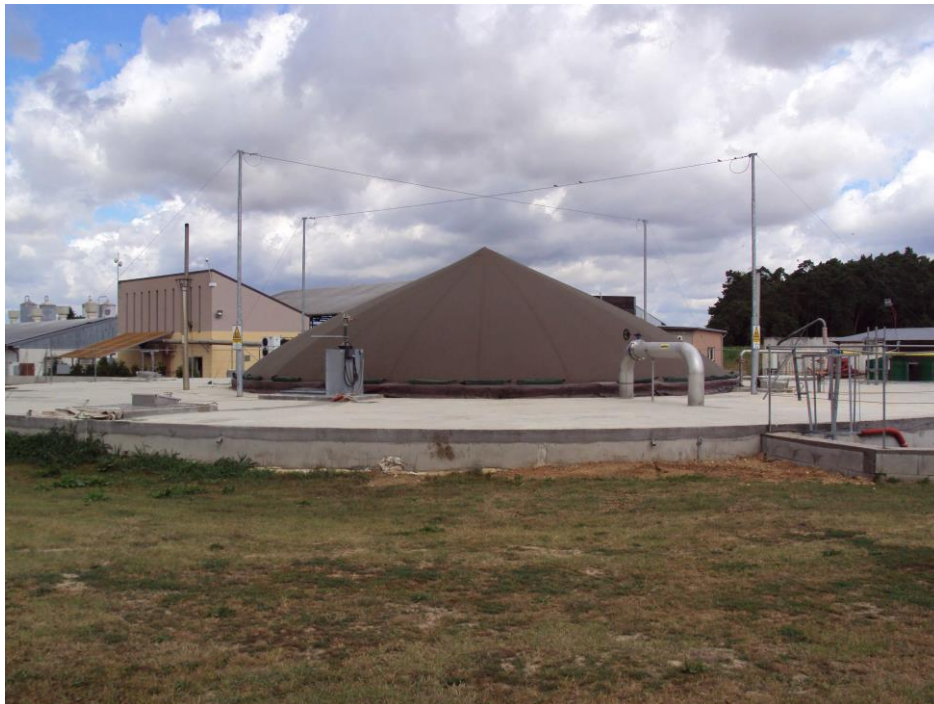
Obrázek 2 – dvouplášťový fermentor BPS Vejprnice
