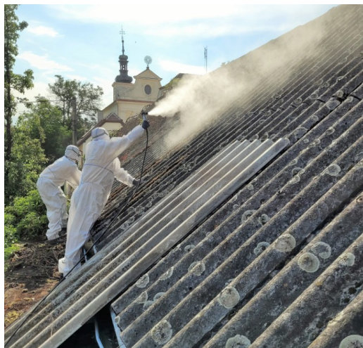
Obrázek 2: Likvidace azbestu ze střechy rodinného domu, Zdroj: www.azbestop.cz , 2024
