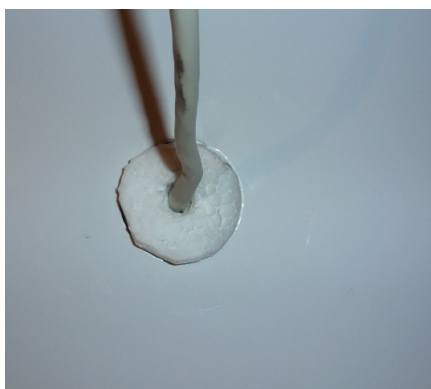
Obrázek 5.4: Detail zapojení teplotního čidla do bojleru
