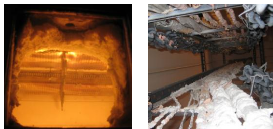
Obr. 3.: Ukázka zkoušky zachování integrity kabelové trasy; vlevo – průběh zkoušky; vpravo – stav kabelů po zkoušce [8]
