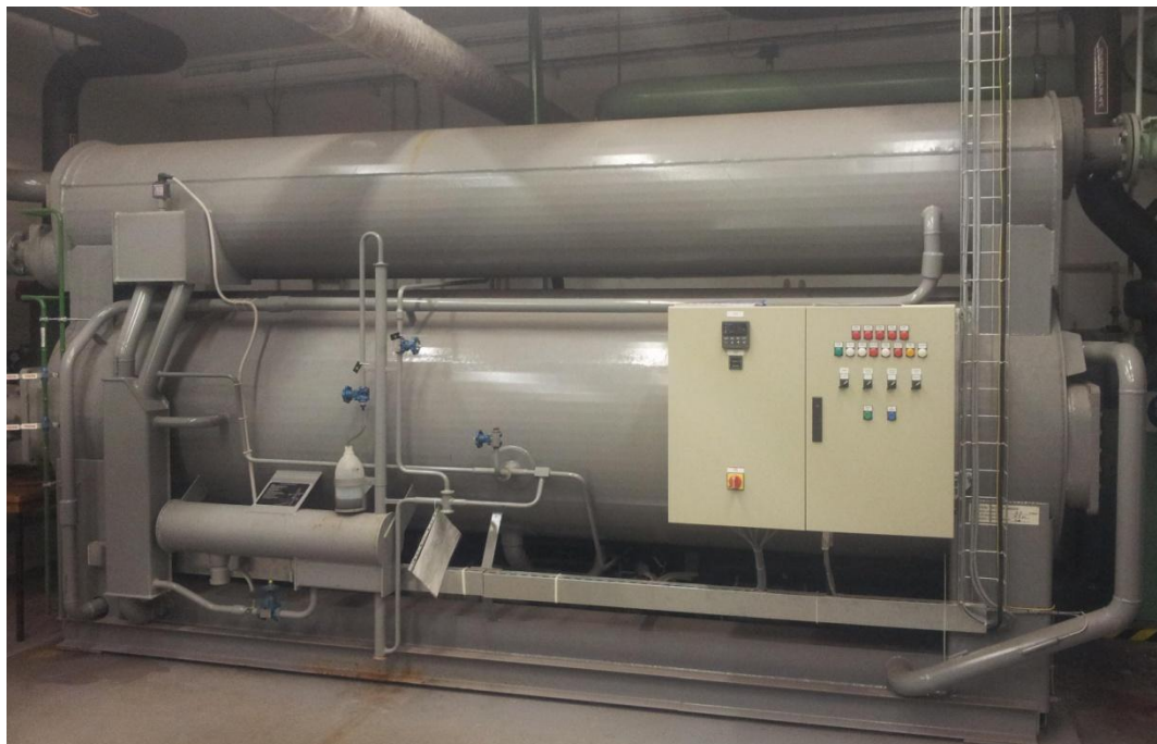
Obr.4 Absorpční chladicí jednotka Carrier 16 JB 021
