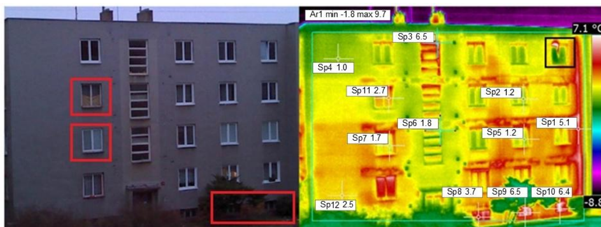
Obr. 12-2: Výsledný termogram společně s reálnou fotografií severovýchodní stěny bytového bloku.
