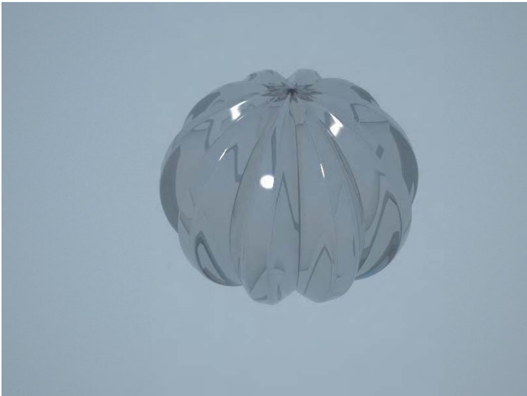
Obrázek 40 - původní tvar realizovaného osvětlení (s ostrými vnitřními rádiusy)
