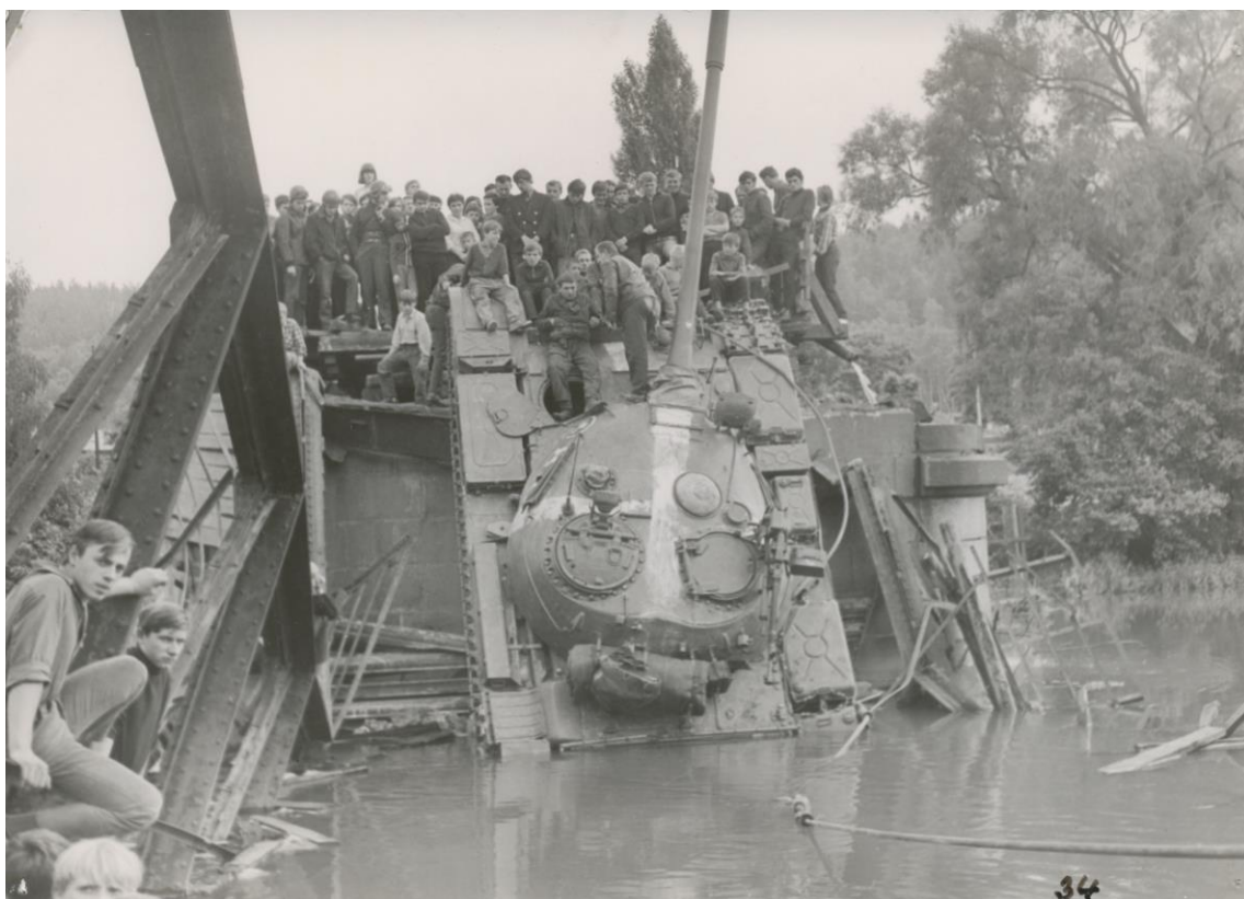
4) Sovětský tank v řece Ohři po zřícení mostu
