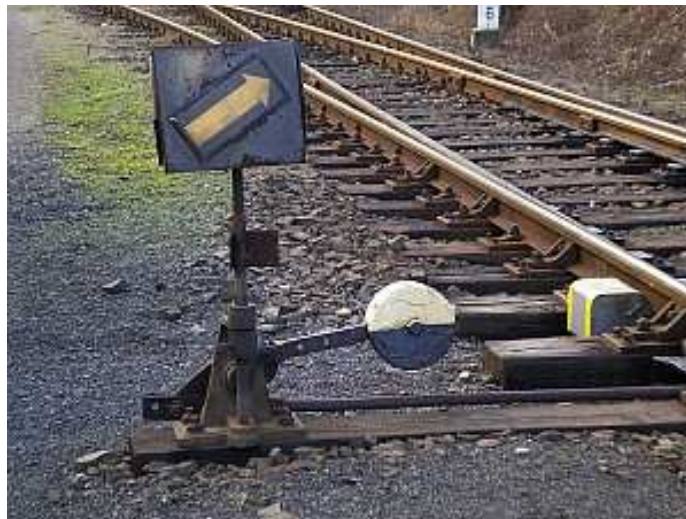
[7] Obr. 3 Výměník ručně stavěné výhybky
