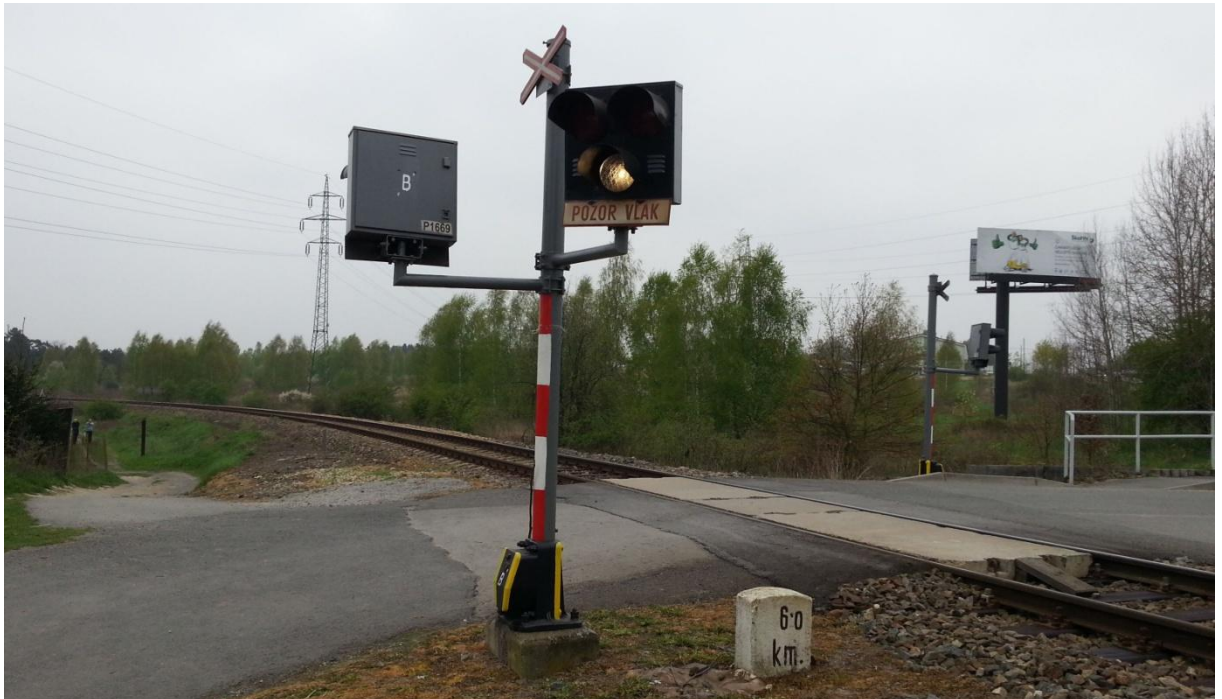
Obrázek 24: Železniční přejezd P1669
