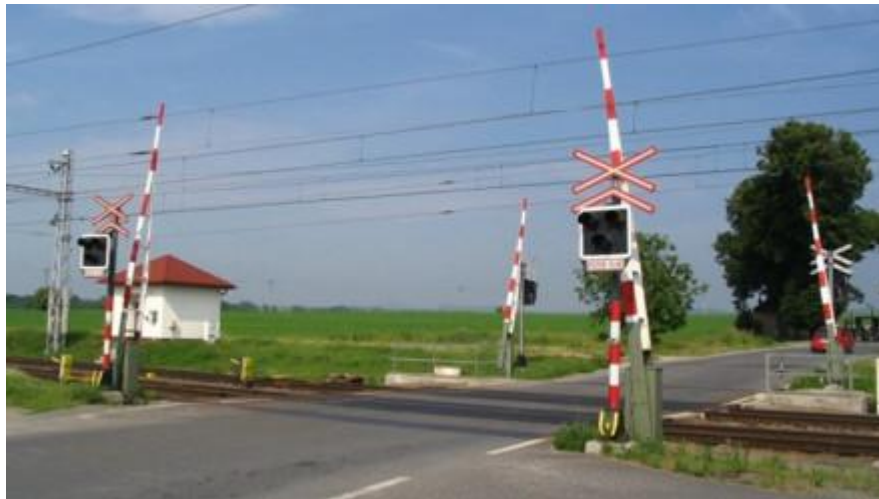
Obr. 7 - Světelné přejezdové zařízení se závorami [11]
