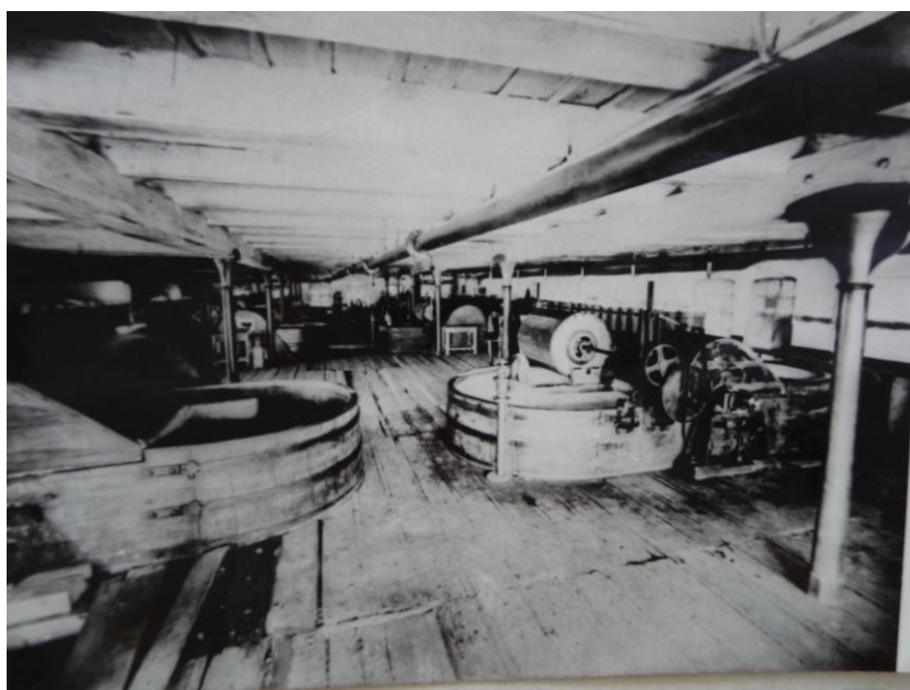
Příloha A 22: Holandry na mletí papíroviny a praní papíroviny s dřevěnou vanou. Fotografie kolem roku 1896.
