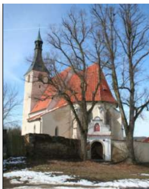
Obr. 2 Rok 2013 - pohled od severozápadu
