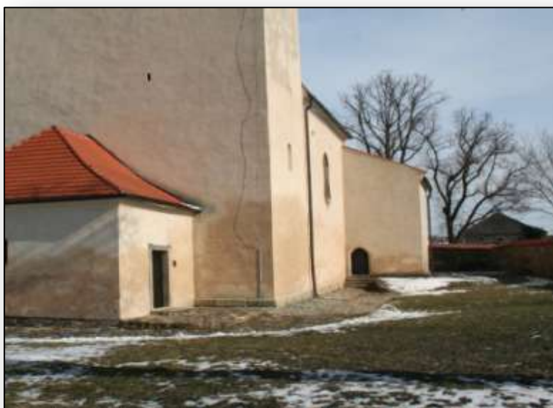
Obr. 6 Rok 2013 - jižní zed' věže a lodi s přistavěnou kaplí (sakristií)
