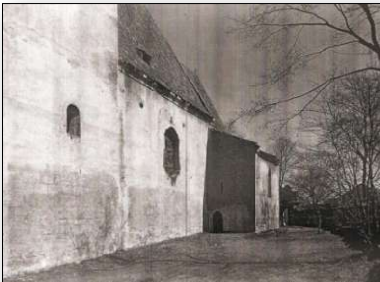
Obr. 5 Rok 1958 - jižní zed' věže a lodi s přistavěnou kaplí (sakristií)
