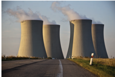
Obrázek 2.25: Chladící věže jaderné elektrárny Temelín
