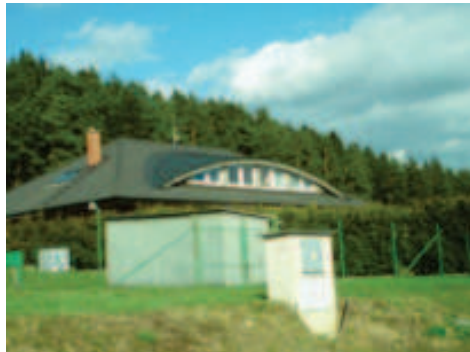
Obrázek 4.8: Přímý parabolický konoid využití v zastřešování budov
